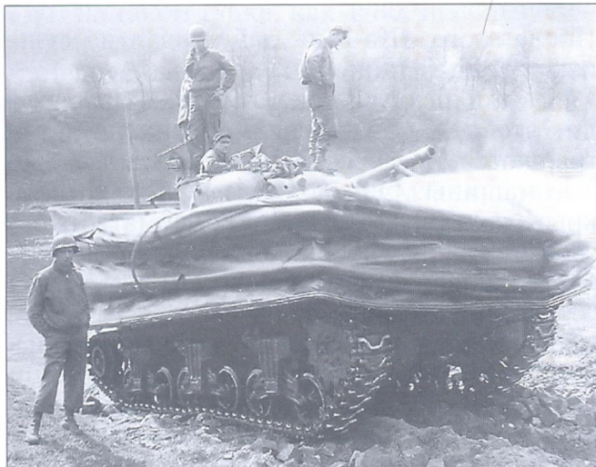
Американский танк «Шерман», оборудованный подъемным экраном
